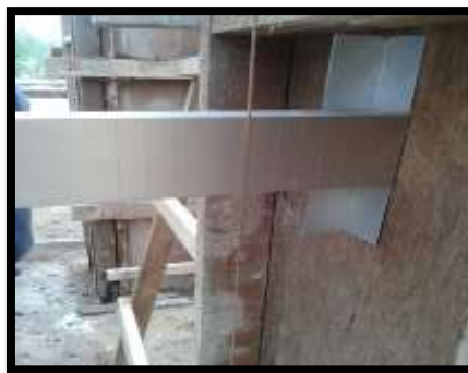
Rajah 11. Pemerhatian kedudukan tali yang berada pada penanda yang dibuat pada alat. Tali yang berada tepat beserenjang dengan tandaan menunjukkan tiang berkedudukan tegak.
