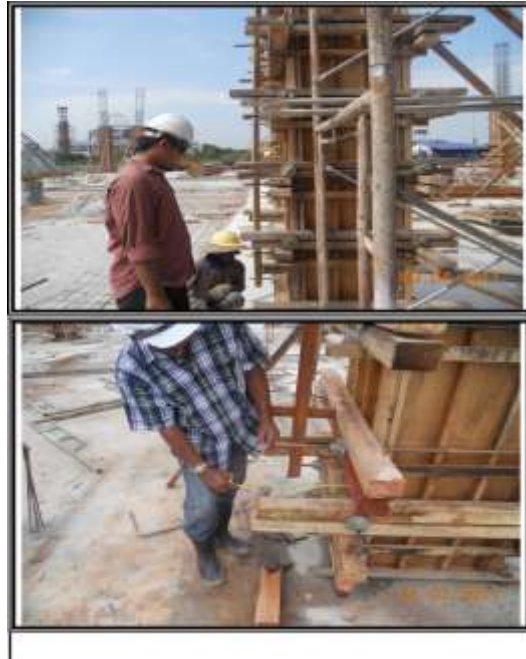
Rajah 1. Pengujian kotak bentuk tiang secara konvensional menggunakan kayu
