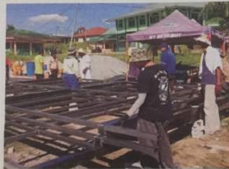
KAKITANGAN PUO dan komuniti pondok Haji Shahrudin menyediakan struktur utama bangunan untuk penginapan pelajar.
